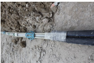
Freyssinet CGA with tube à manchettes
